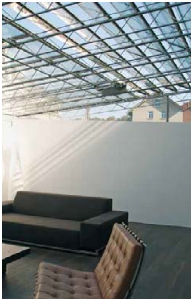
Innenansicht eines Wintergartens: Die Glas-lamellen öffnen und schliessen sich automatisch und stufenlos – selbst bei Regen garantieren sie eine optimale Belüftung.
