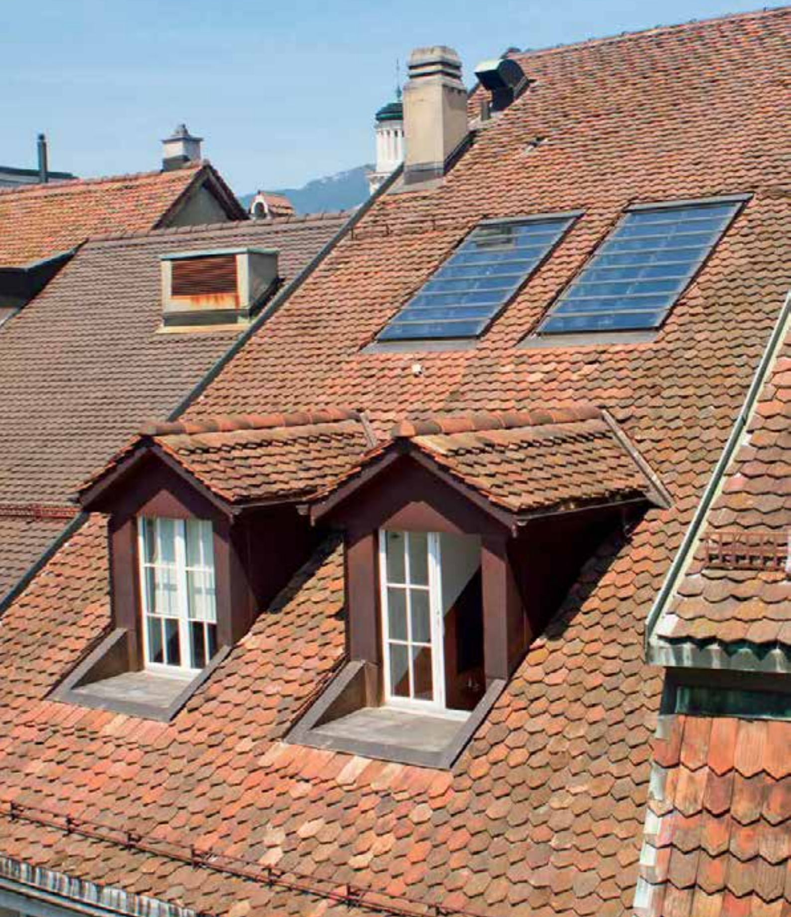
Die beiden Lamellendachfenster schaffen nebst den bestehenden Giebelfenstern zusätzliche Lichtquellen. | Les deux fenêtres de toit à lamelles ajoutent de la lumière aux deux pignons existants.
