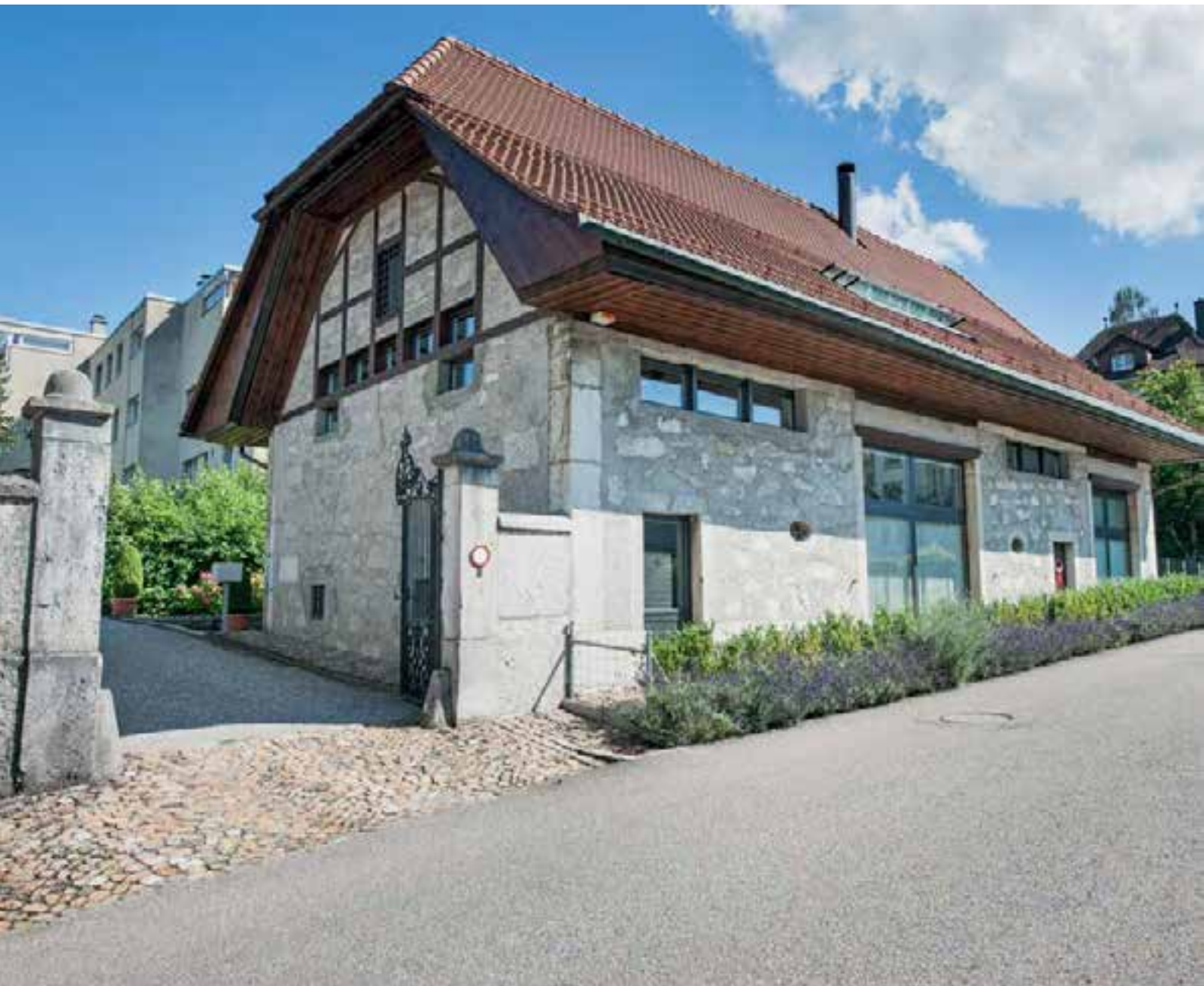
Das Gebäude an der Alten Bernstrasse ist Teil des barocken Landsitzes «Weisse Laus» – eines der wichtigsten seiner Art in Solothurn und Umgebung. Le bâtiment sur l'Alten Bernstrasse fait partie du manoir baroque «Weisse Laus» – l'un des plus typiques du pays soleurois.
