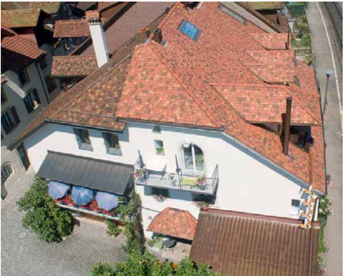
Die Lamellen- und Festglasfenster bringen Licht ins Dachgeschoss. | Les fenêtres à lamelles et les verres fixes éclairent les combles.
